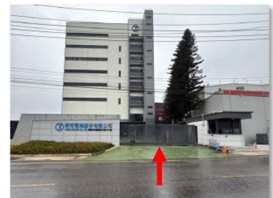
停車場入口位於警衛室旁
